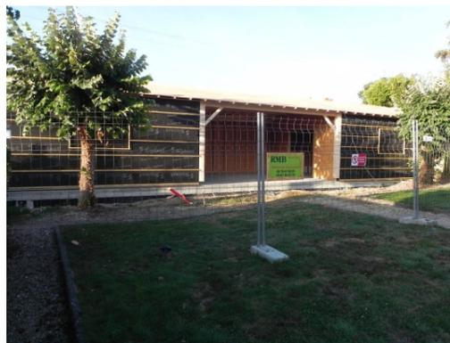
Le chantier de construction du local de stockage lancé au cours de l'été prend forme et respecte son calendrier d'interventions. Les lots 1 (gros œuvre maçonnerie) 2 et 3 (ossature bois, toiture et zinguerie) sont achevés.
